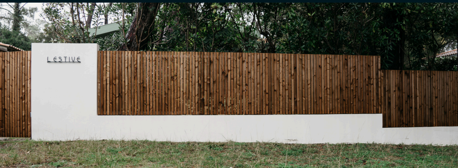
cadre galvanisé à chaud + remplissage liteaux épicéa
