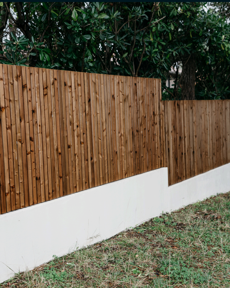
cadre galvanisé à chaud + remplissage liteaux épicéa
