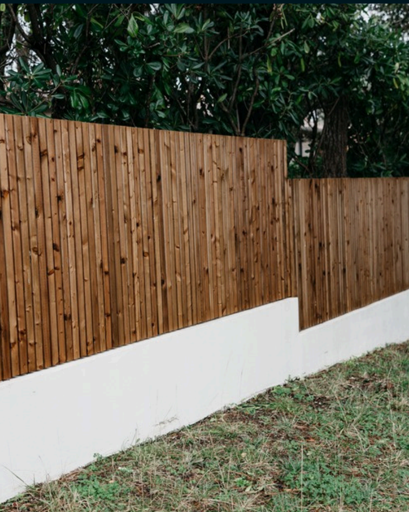
cadre galvanisé à chaud + remplissage liteaux épicéa
