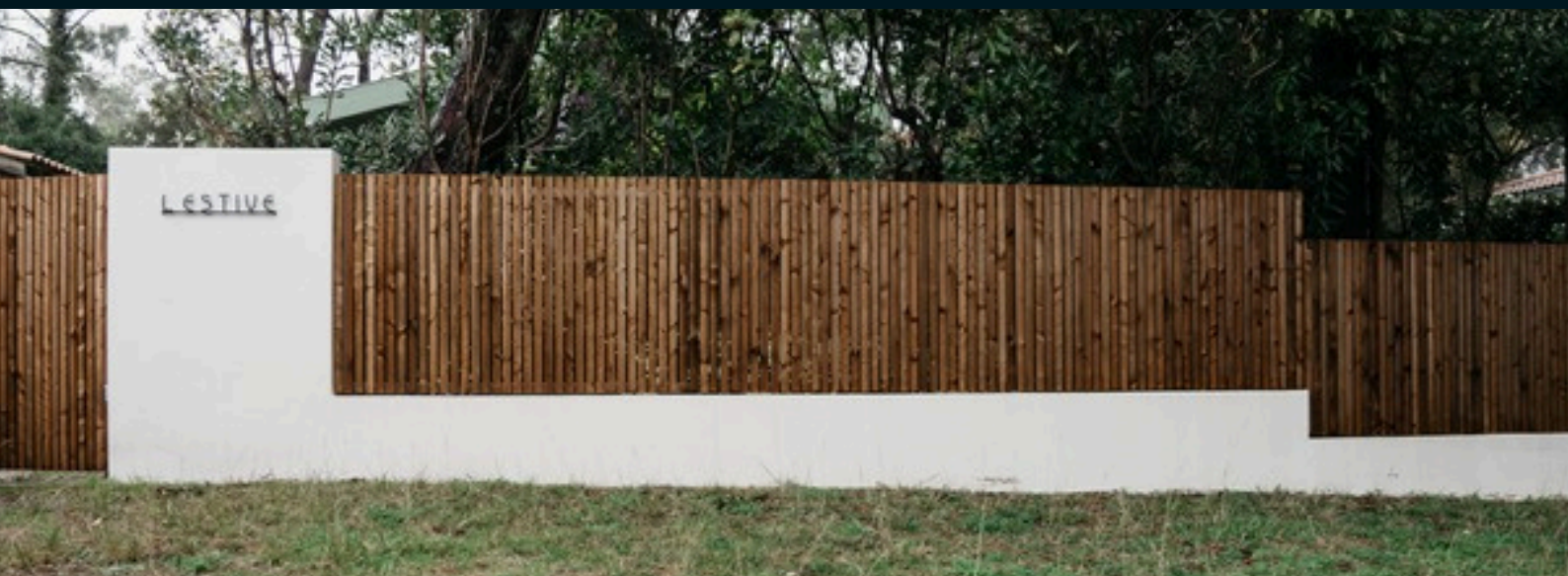
cadre galvanisé à chaud + remplissage liteaux épicéa
