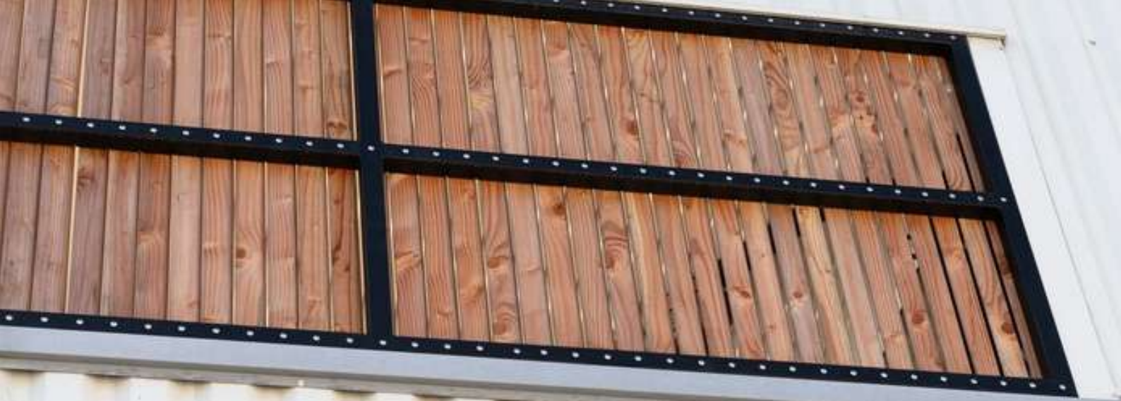
cadre thermolaqué RAL 9005 noir + remplissage liteaux douglas biaises
