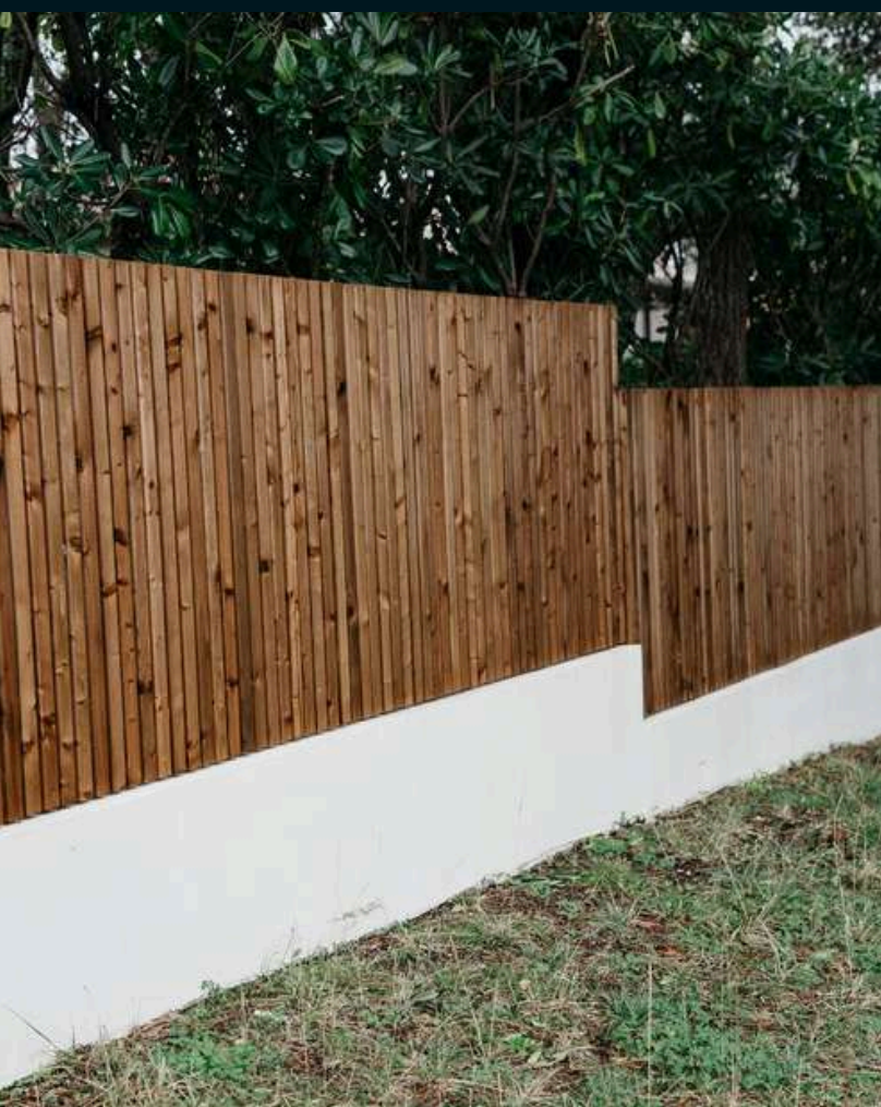
cadre galvanisé à chaud + remplissage liteaux épicéa
